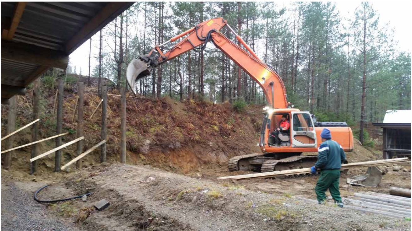
Syksyn aikana ampumaradalla tehtiin maansiirtotöitä suojavallien korottamiseksi.
